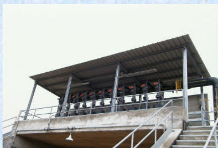
Foto delle sottostazioni
