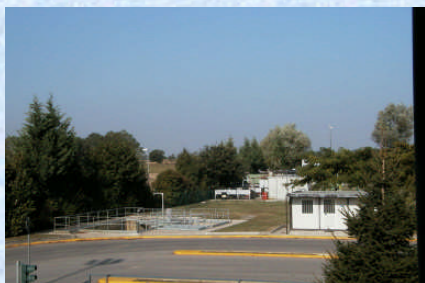
"Vasca di prima pioggia"
