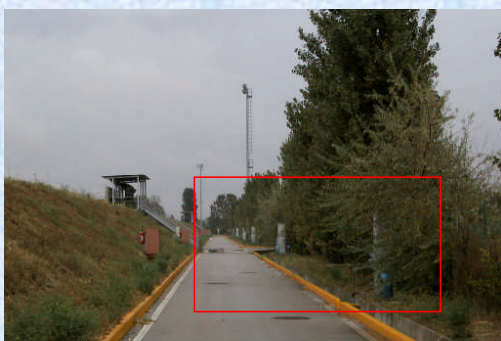
BATTERIA DI PIEZOMETRI
