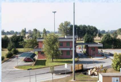
"Palazzina Uffici – Impianto lava ruote Sistema doppia pesatura"
